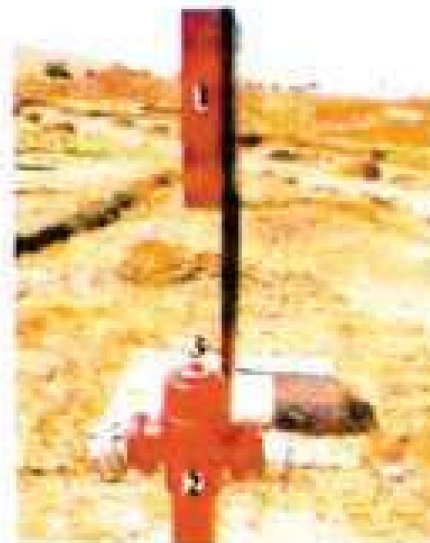
ΣΧ. 10.2.2.β Δίδυμο πυροσβεστικό υδροστόμιο σε υπαίθριο χώρο.
