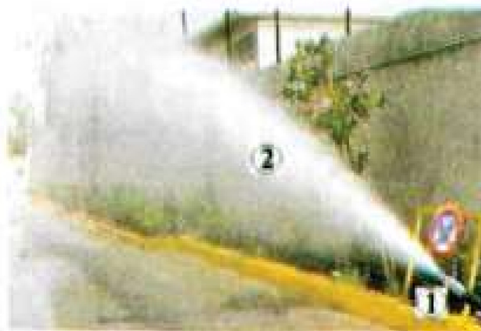
ΣΧ.10.5.α Ο τακτικός έλεγχος καλής λειτουργίας διασφαλίζει την ετοιμότητα ενός μόνιμου πυροσβεστικού δικτύου.
