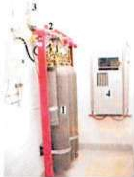
ΣΧ. 10.4.α Σταθμός διοξειδίου του άνθρακα ( \text{CO}_2 ). Διακρίνονται οι φιάλες αποθήκευσης του αερίου (1), το σύστημα στήριξης τους (2), οι σωληνώσεις (3) και ο ηλεκτρονικός πίνακας ενεργοποίησης της εκκένωσης μόλις δοθεί από τους ανιχνευτές η πληροφορία για φωτιά. (4). Σημειώνουμε ότι το \text{CO}_2 αποθηκεύεται υπό υψηλή πίεση.
