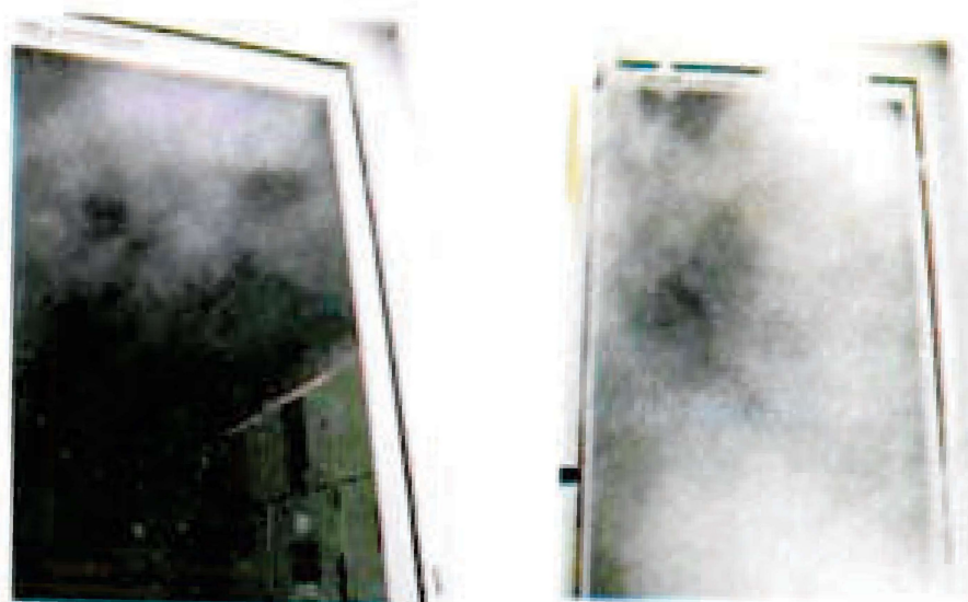
ΣΧ.10.4.γ Αριστερά μόλις έχει αρχίσει η εκκένωση διοξειδίου του άνθρακα πάνω από τους ηλεκτρικούς πίνακες. Δεξιά, το \text{CO}_2 έχει κατακλύσει όλο τον χώρο. Οι συνθήκες είναι αποπνικτικές και ιδιαίτερα επικίνδυνες.
